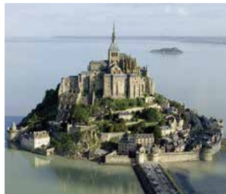
フランス モンサンミシエルの水門設備
