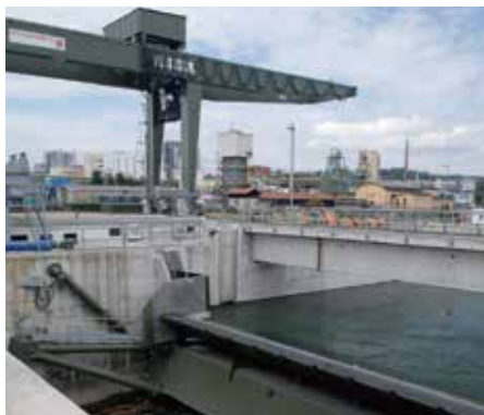
ドイツ ライン川発電設備
