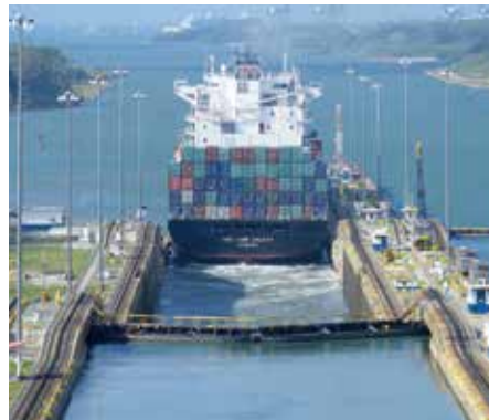
パナマ運河 水門設備
