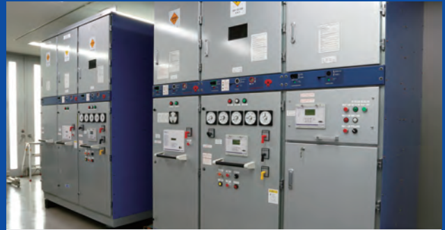
高圧配電盤シミュレータ
